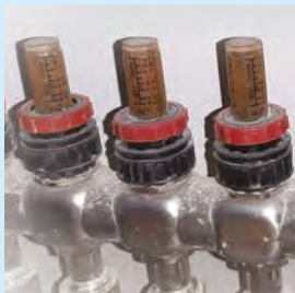
Jakotukin virtausmittarit samentumat.
